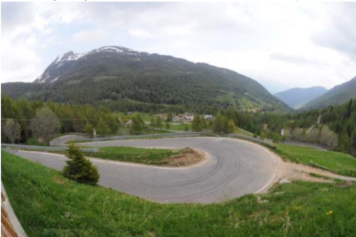
The road we drove up to Passo di Mortirolo. Notice the damaged guardrail.
